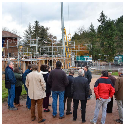
Fig. 25 : Visite du chantier de l'extension de Coforêt suite au COPIL de la CFT, 2019.
