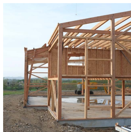
Fig. 18 : Construction d'un bâtiment tertiaire en bois, 2018.
