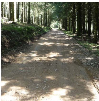
Fig. 8 : Rénovation de la voirie forestière de Saint-Nizier-d'Azergue, 2020.
