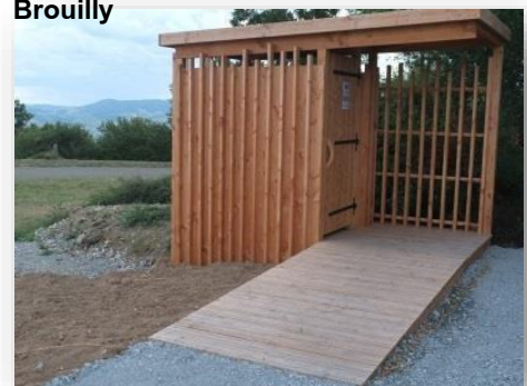
Toilette sèche 100% bois local Mont Brouilly
