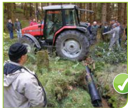
Tube PEHD* recouvert de rondins
