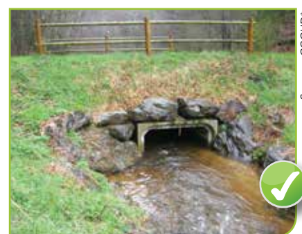
Buse cadre enterrée au 1/3
