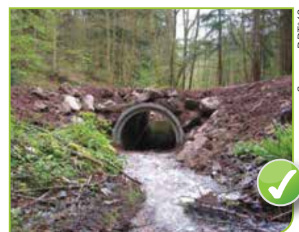
Buse circulaire enterrée au 1/3
