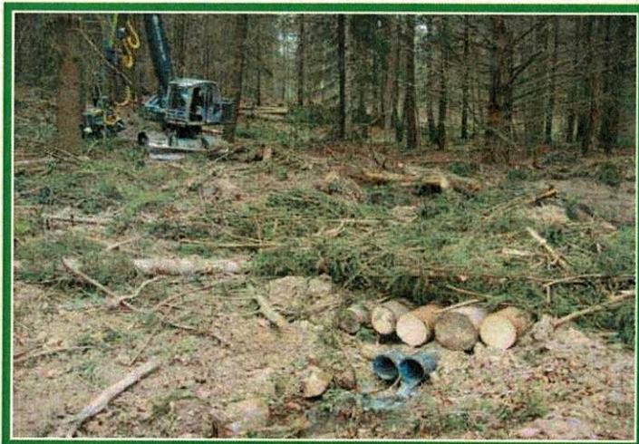
Les Tuyaux sont placés au milieu du cours d'eau, là où le débit est le plus important et recouvert de billons prélevés sur la coupe pour arriver au niveau de la berge. Il ne doit pas y avoir de chute d'eau à la sortie des tuyaux. En cas de fond vaseux, mettre un géotextile sous les tuyaux pour éviter un enfoncement. Les tuyaux sont rendus solidaires en faisant passer un câble qui servira aussi à l'arrimage aux berges en cas de fort débit.
