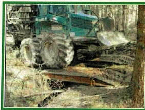
Des billons ou une rampe métallique de plus de 2 m par rapport à la largeur du cours d'eau, sont disposés en travers du cours d'eau, les extrémités reposant sur chaque berge. Le terrain doit être porteur et plat, et les berges bien marquées (espace suffisant entre le pont et le niveau d'eau). Caler l'installation sur une berge stable (contre une souche par exemple) et attacher les rondins avec une chaîne.
